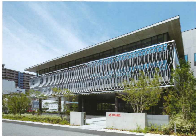
日射遮蔽、視線制御、自然採光・通風に配慮した企業のアイデンティティを現す「環縫いルーバー」と歩行者に配慮した緑豊かな外構計画 撮影：プライズ 山崎浩治
